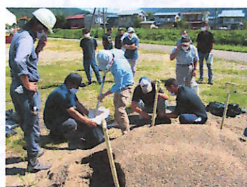
土のう作成訓練
