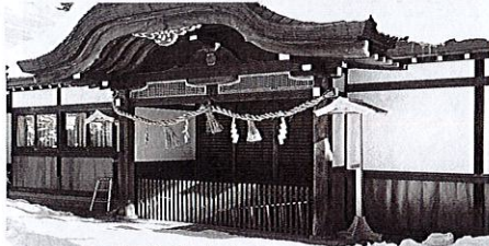
提灯台と修復された白壁及び板壁
