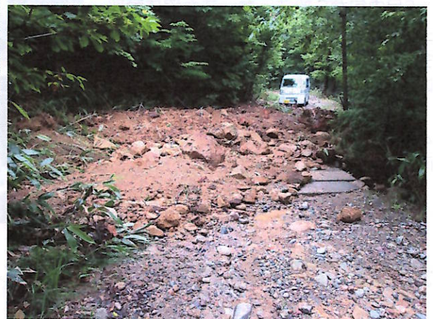
苅安林道 (土砂崩れ)
